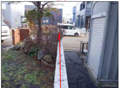
③ E1~E2境界線を跨いで本地ブロック塀がある。 E2方向
