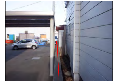
⑥ E1~E5境界線を跨いで本地ブロック塀がある。 E5方向
