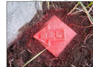
既設ダクトイル標 E4
